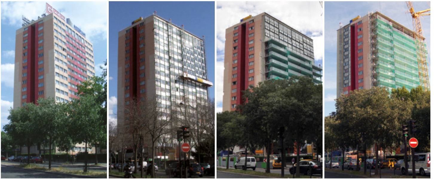
Photo 1 : état des lieux, 1990 - Photos 2, 3, 4 : transformation 2010 / 2011, chantier en site occupé
