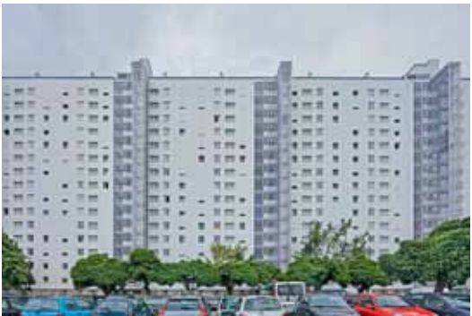
Auf der Nordseite der Gebäuderiegel wurden die vorgesetzten Treppen- und Aufzugstürme neu gestaltet. Zwei kleine Aufzüge für jeweils 45 Wohnungen wurden durch einen größeren ersetzt und ein weiterer Aufzug angefügt.
