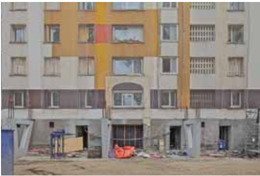
Bei den Loggien handelt es sich um eine vorgesetzte, an den Bestand angefügte Fertigteilkonstruktion. In die Struktur der Gebäude wurde nicht eingegriffen.
