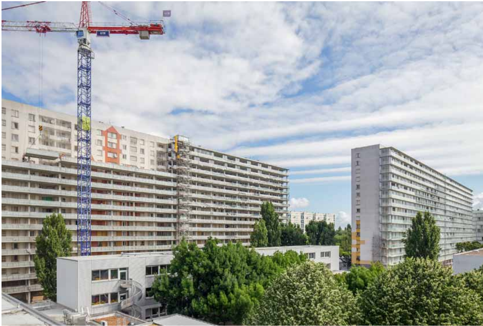
Montage der immer gleichen, auf der Südseite vorgesetzten Betonmodule. Rechts oben der Gebäuderiegel mit bereits fertiggestellter Ergänzung.
