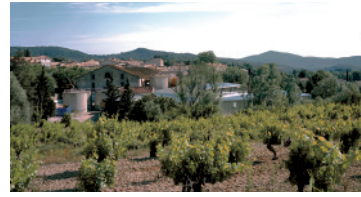
Cave, Embrès et Castelmaure Réalisation 2007 Maître d'ouvrage SCV Embrès et Castelmaure Programme Caves et chais, neuf et rénovation Surface 2 000 m 2 (neuf) + 400 m 2 (rénové) Coût 1,1 M€ HT
