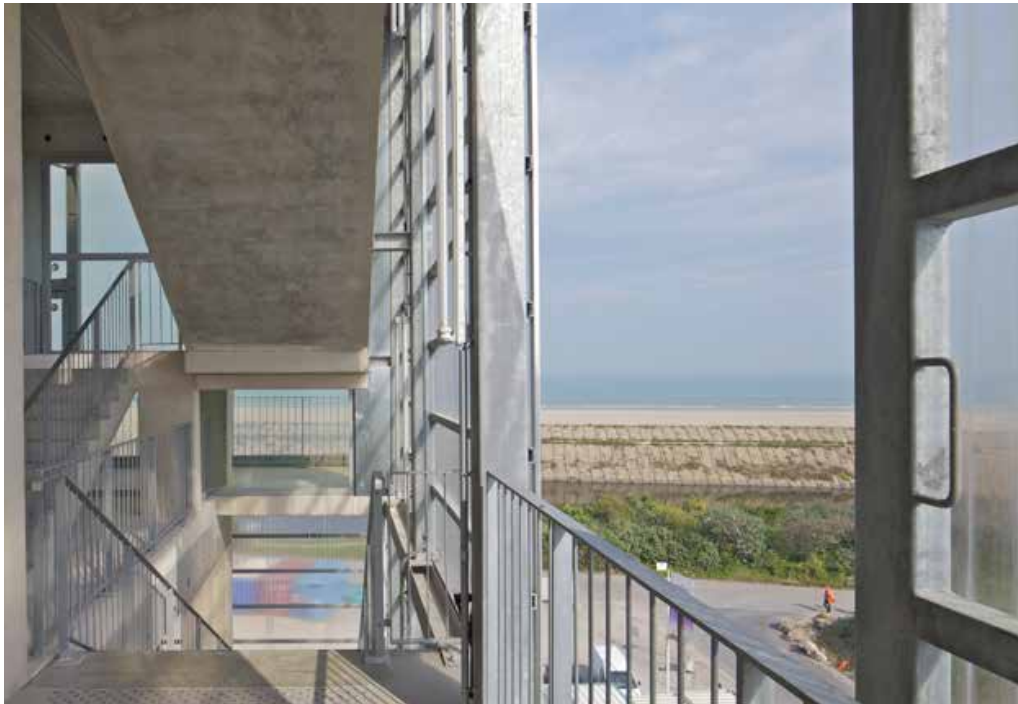
Staircase in the FRAC Nord-Pas de Calais, Dunkirk, with moveable transparent panels / Traphal in het FRAC Nord-Pas de Calais, Duinkerken, met verschuifbare transparante panelen
