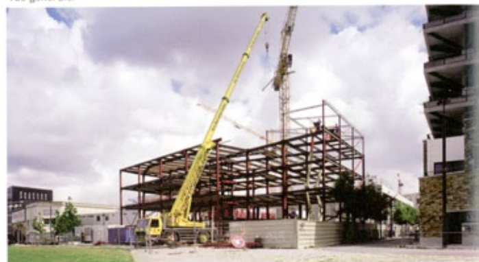
Montage de la structure en acier.
