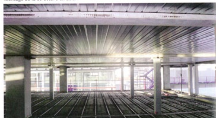
Vue d'une salle en cours de chantier.
