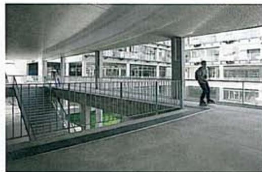
Die sichtbar belassene Tragstruktur besteht aus Betonfertigteilen. Der große Innenhof (Foto links) ist nach Südwesten orientiert. Die Gemeinschaftsbereiche sind mit Aluminiumblech verkleidet.
