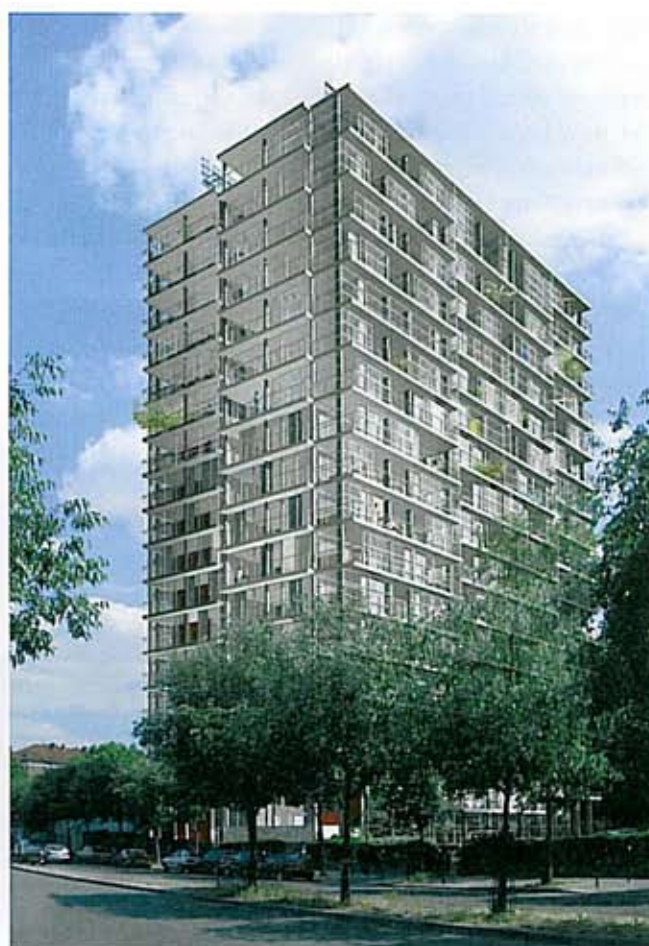
Der Tour Bois-le-Prêtre in Paris im Jahr 1961, nach der haustechnischen Sanierung 1990 und nach dem geplanten Umbau 2008.
