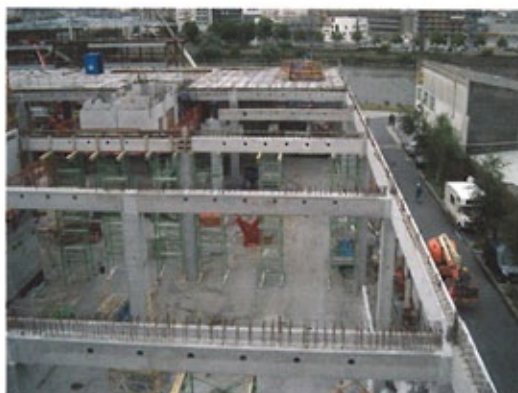
Une ossature en béton de grande portée pour l'école d'architecture de Nantes.
