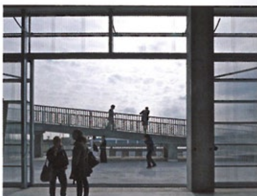
Une ossature en béton de grande portée pour l'école d'architecture de Nantes.
