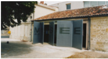
Musée archéologique, Saintes Réalisation 1995 Maître d'ouvrage Ville de Saintes Surface 135 m2 Coût 70 000 € HT (val. 1995)
