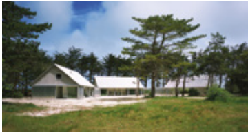
Maison Keremma, Trélez Réalisation 2005 Maître d'ouvrage Privé Programme Maison individuelle Surface 316 m2 SHON Coût 260 000 € HT
