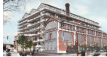
Ecole d'architecture Paris Val-de-Seine, Paris 13 Concours 2002, non lauréat Maître d'ouvrage Ministère de la Culture Programme Restructuration et importante extension des usines SUDAC Surface 19 755 m2 neuf + 1 015 m2 réhabilitation Coût 21,35 M €
