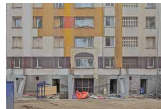
Bei den Loggien handelt es sich um eine vorgefertigte, an den Bestand angefügte Fertigteilkonstruktion. In die Struktur der Gebäude wurde nicht eingegriffen.
