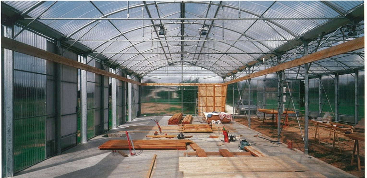
Casa en Coutras, Francia (2000) House in Coutras, France
