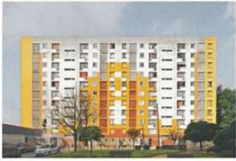
Antes de la intervención Before refurbishment
